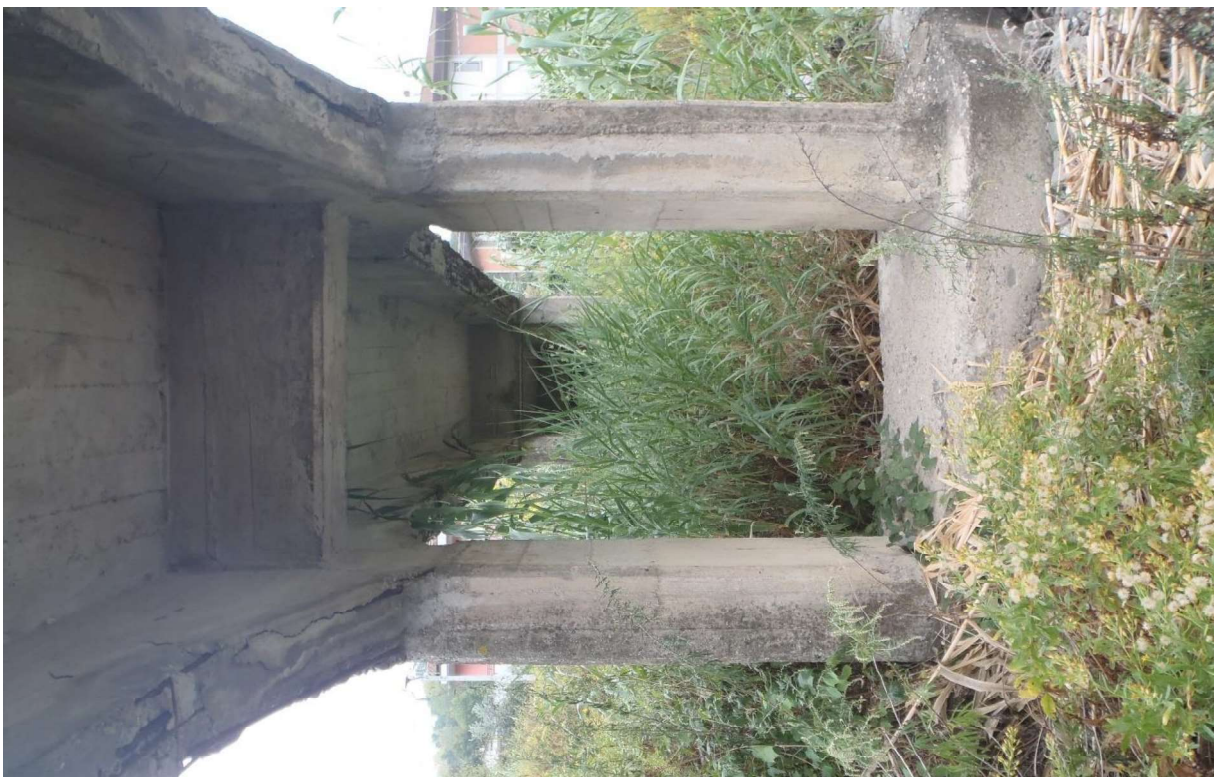
Figura 2.6 – Vista dei pilastri della terza pila da sinistra in direzione sponda sinistra
