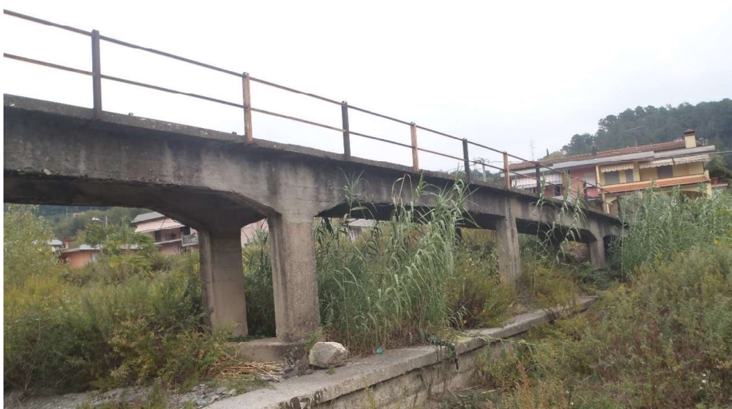
Figura 1.2 – Vista del ponte da valle in direzione della sponda sinistra
