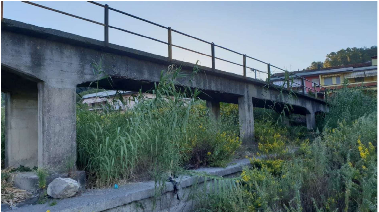
Figura 2.4 – Vista dalla sponda destra lato monte
