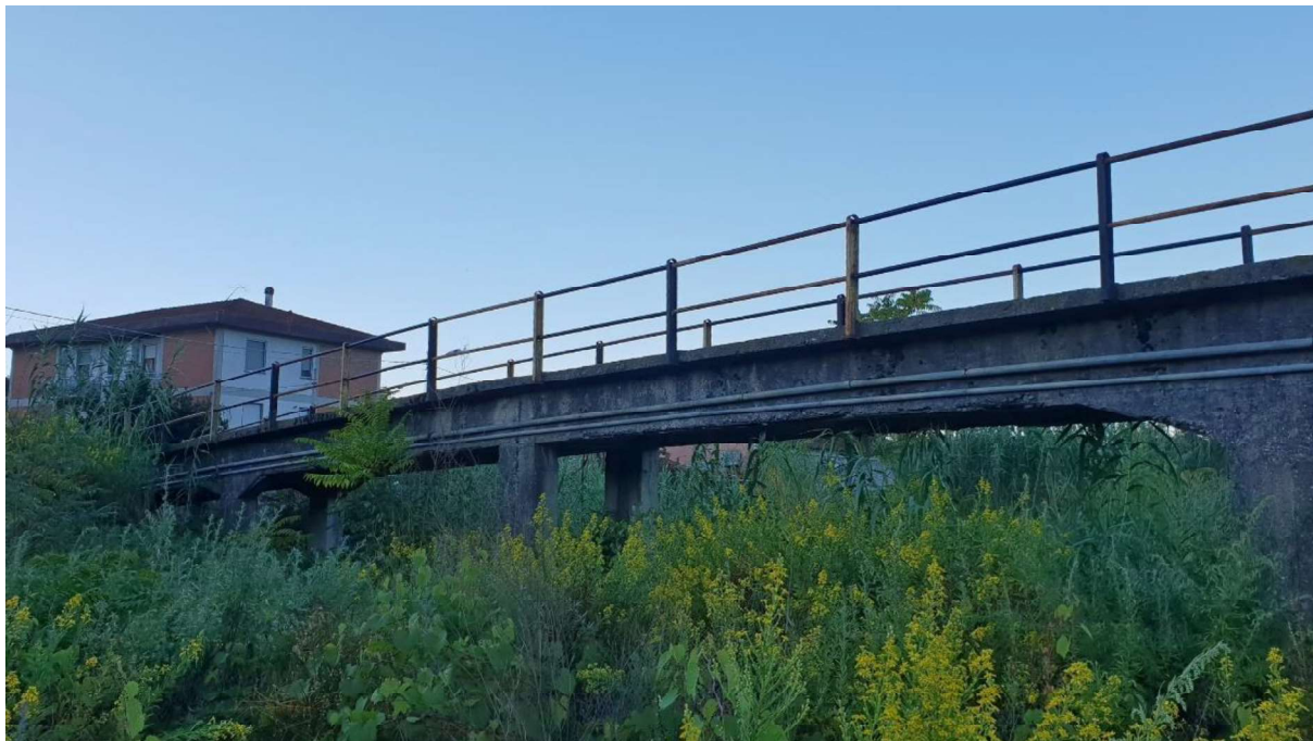
Figura 2.2 – Vista dalla sponda destra lato monte
