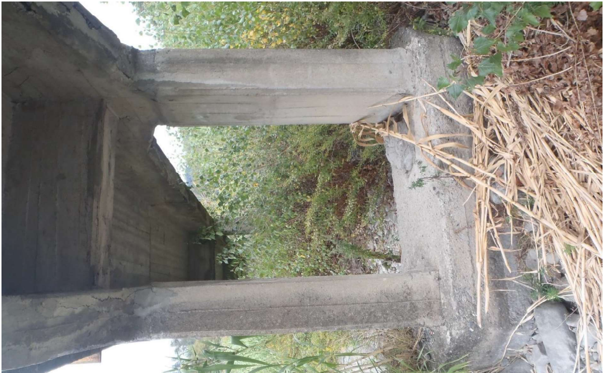
Figura 2.5 – Vista dei pilastri della terza pila da destra in direzione sponda destra
