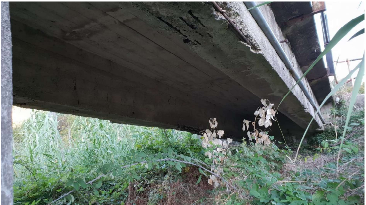
Figura 2.12 – Vista dall'intradosso della struttura da monte della prima campata in sponda destra.
