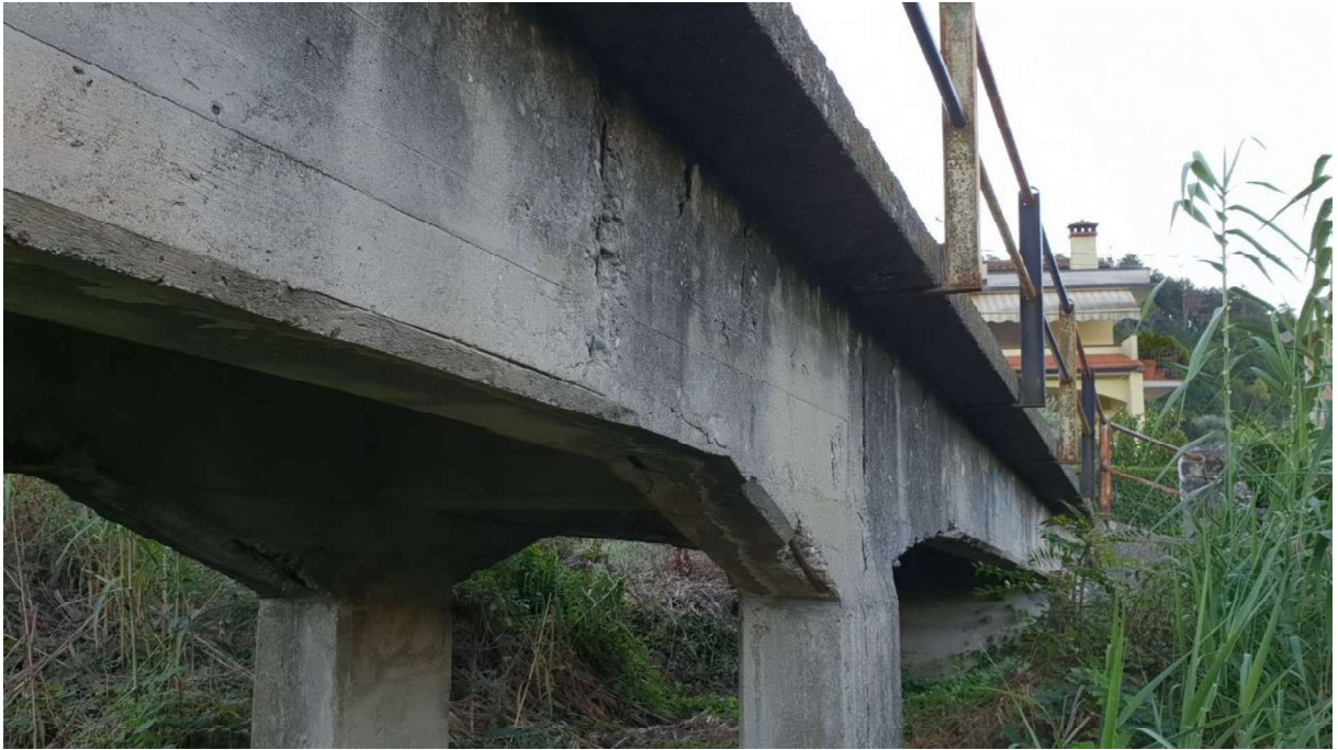
Figura 2.15 – Vista da valle della prima coppia di pilastri in sponda sinistra
