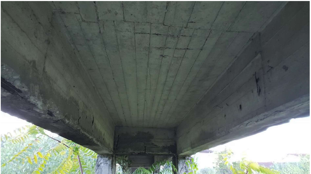
Figura 2.8 – Vista dell'intradosso della soletta
