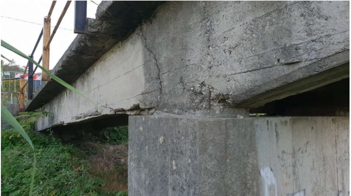
Figura 2.9 – Vista da valle dal sotto in prossimità della sponda destra e della trave
