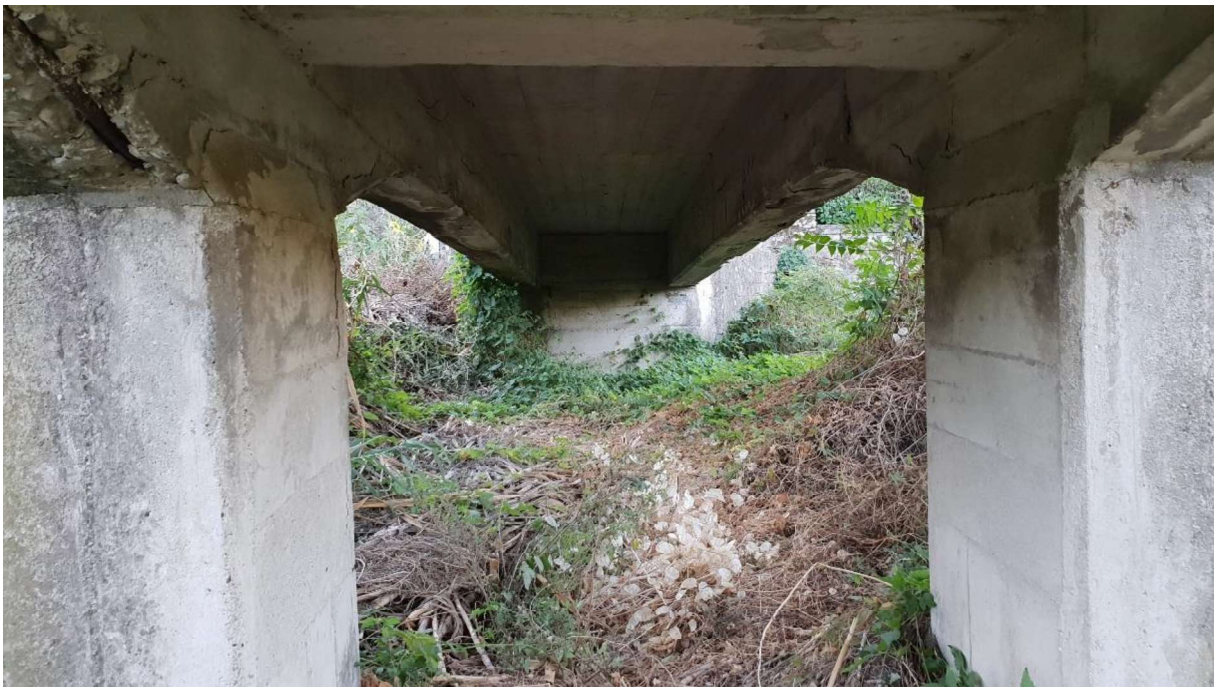
Figura 2.14 – Vista dall'intradosso della struttura della prima campata in sponda sinistra
