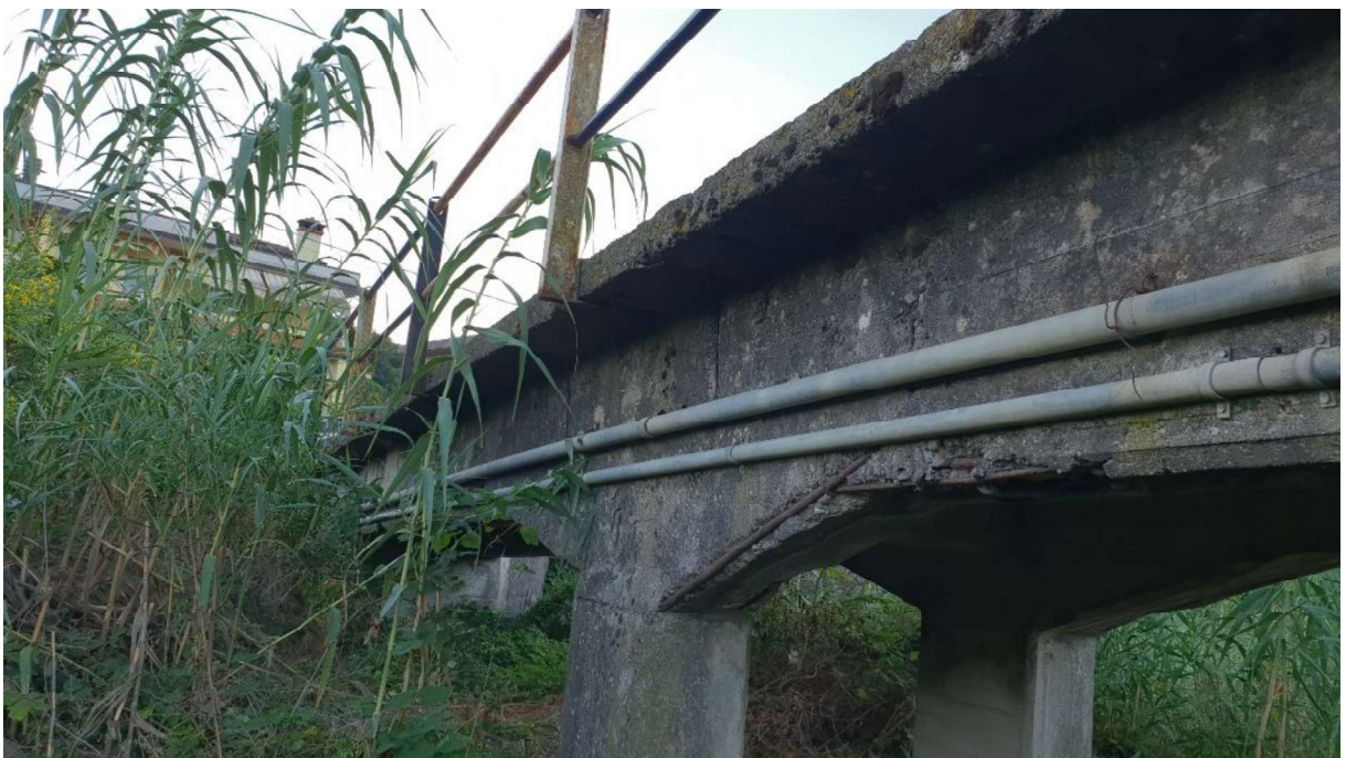
Figura 2.16 – Vista da monte della prima coppia di pilastri in sponda sinistra
