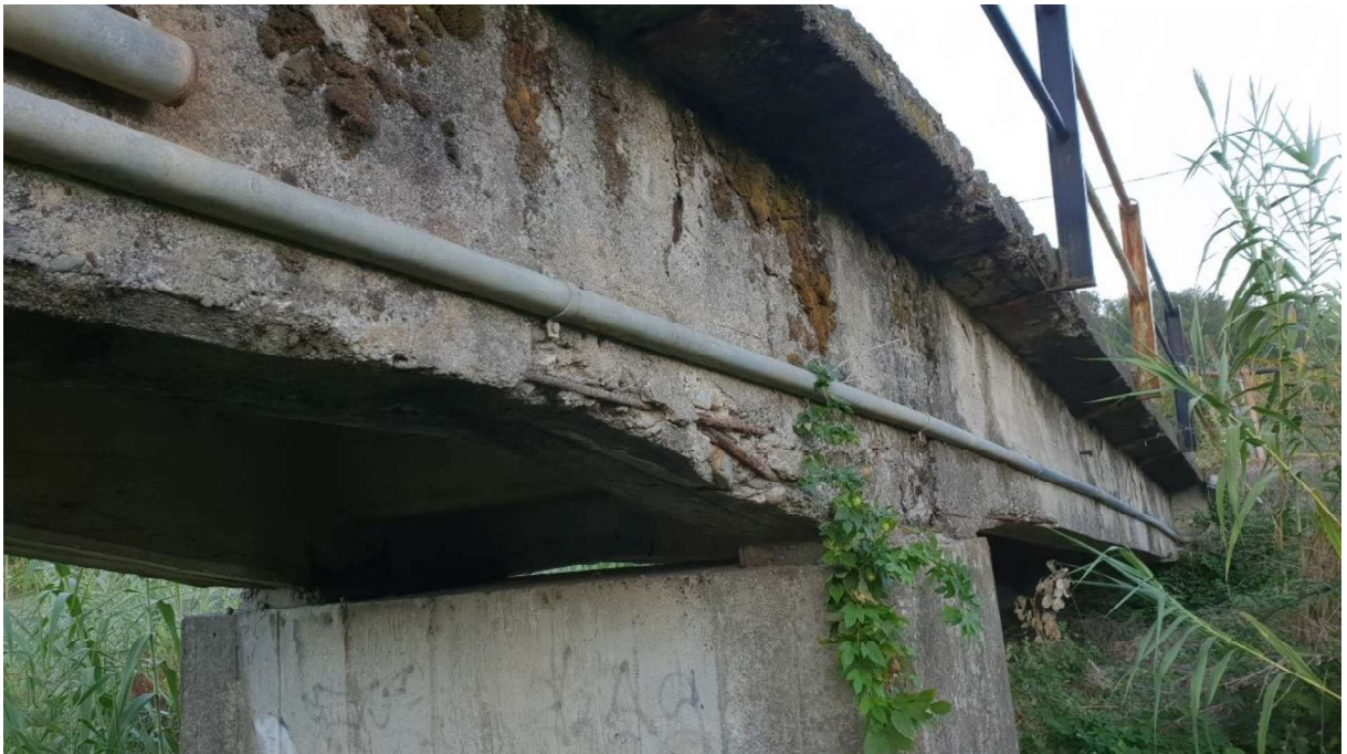
Figura 2.10 – Vista da valle dal sotto in prossimità della sponda destra e della trave
