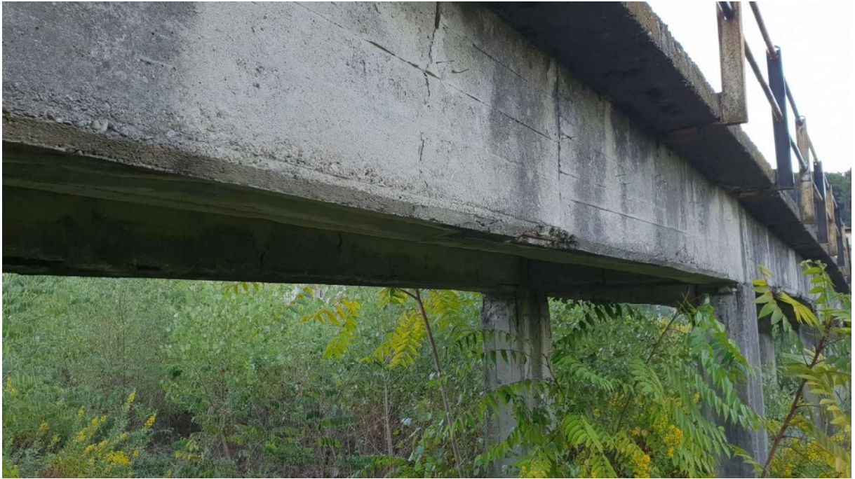
Figura 2.11 – Vista da valle della trave principale della seconda campata da destra
