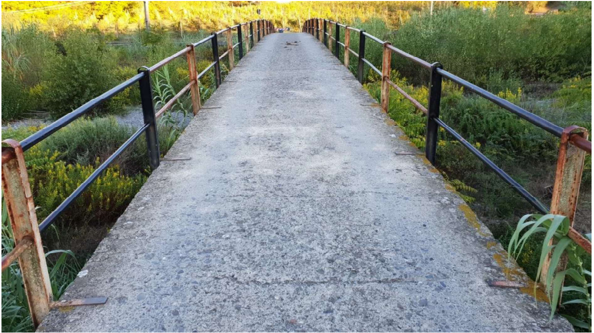
Figura 2.7 – Vista dall'estradosso della soletta di larghezza 2.65 mli
